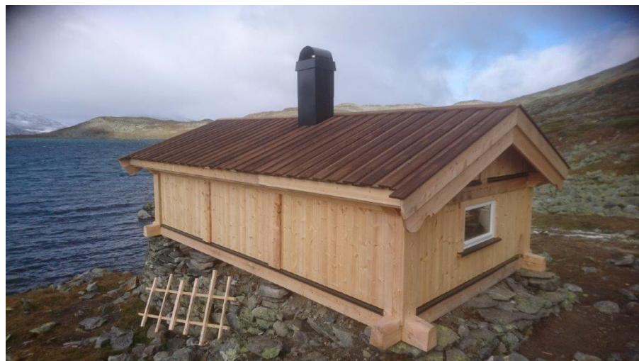
Bilde 8: Stokk og Stein vart ferdige med bygningsarbeidet til 15. september
